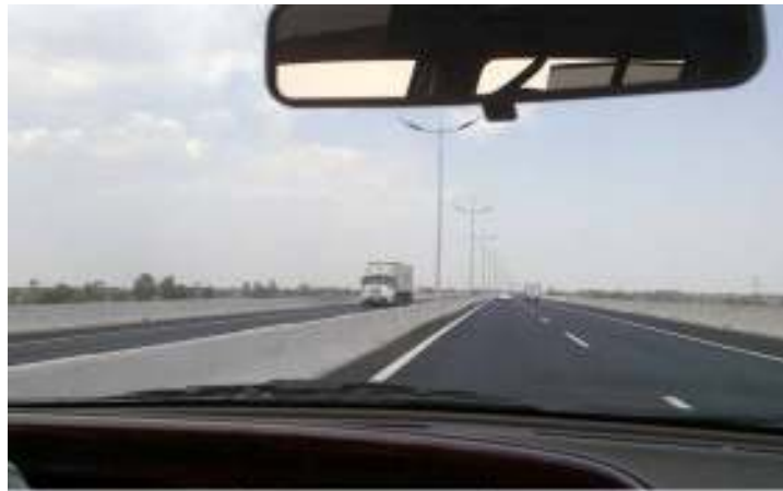
THÔNG XE TRÊN CẦU CẠN ĐƯỜNG CAO TỐC TP HCM - TRUNG LƯƠNG HỢP ĐỒNG 4.1 DO CÔNG TY CPXDCT 510 THI CÔNG
