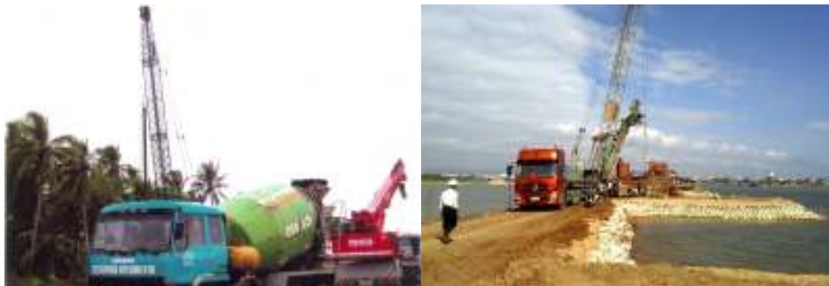
Xe vận chuyển thi công công trình
