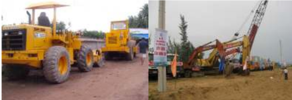
Thiết bị thi công: xe xúc lật, máy đào...
