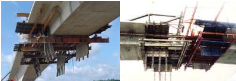
Xe đúc hẫng cân bằng đối xứng
