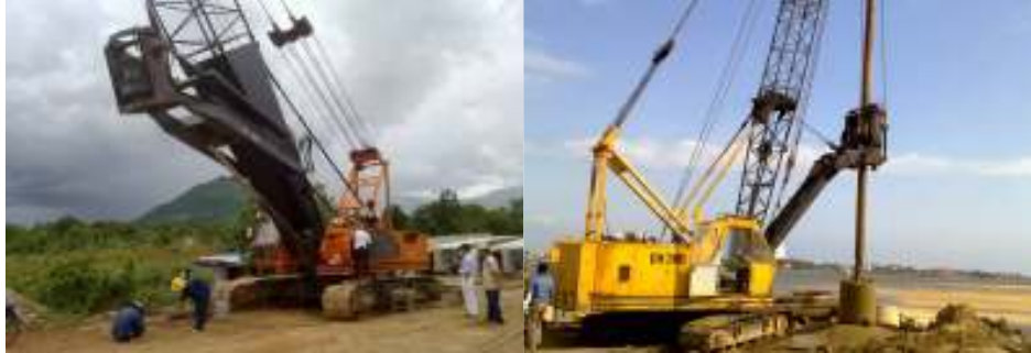
Thiết bị khoan cọc nhồi
