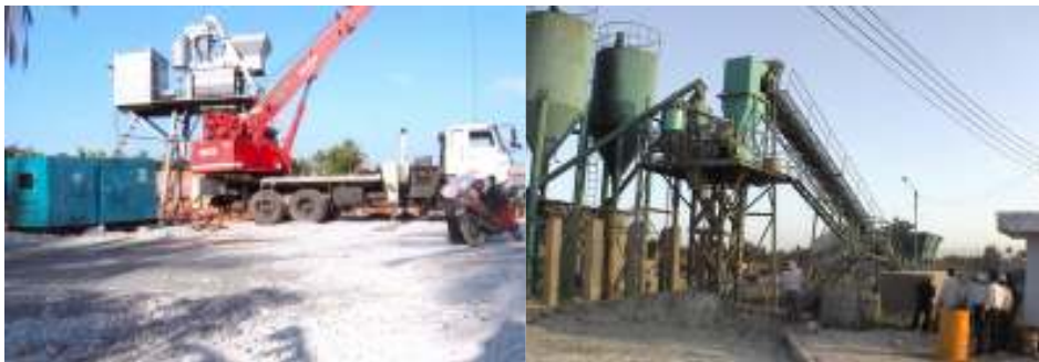
Trạm trộn bê tông tươi 45m 3 /h
