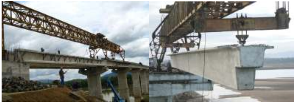
Thiết bị lao lắp dầm cầu
