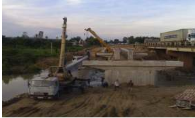
Công trình 10 cầu trên QL1A
